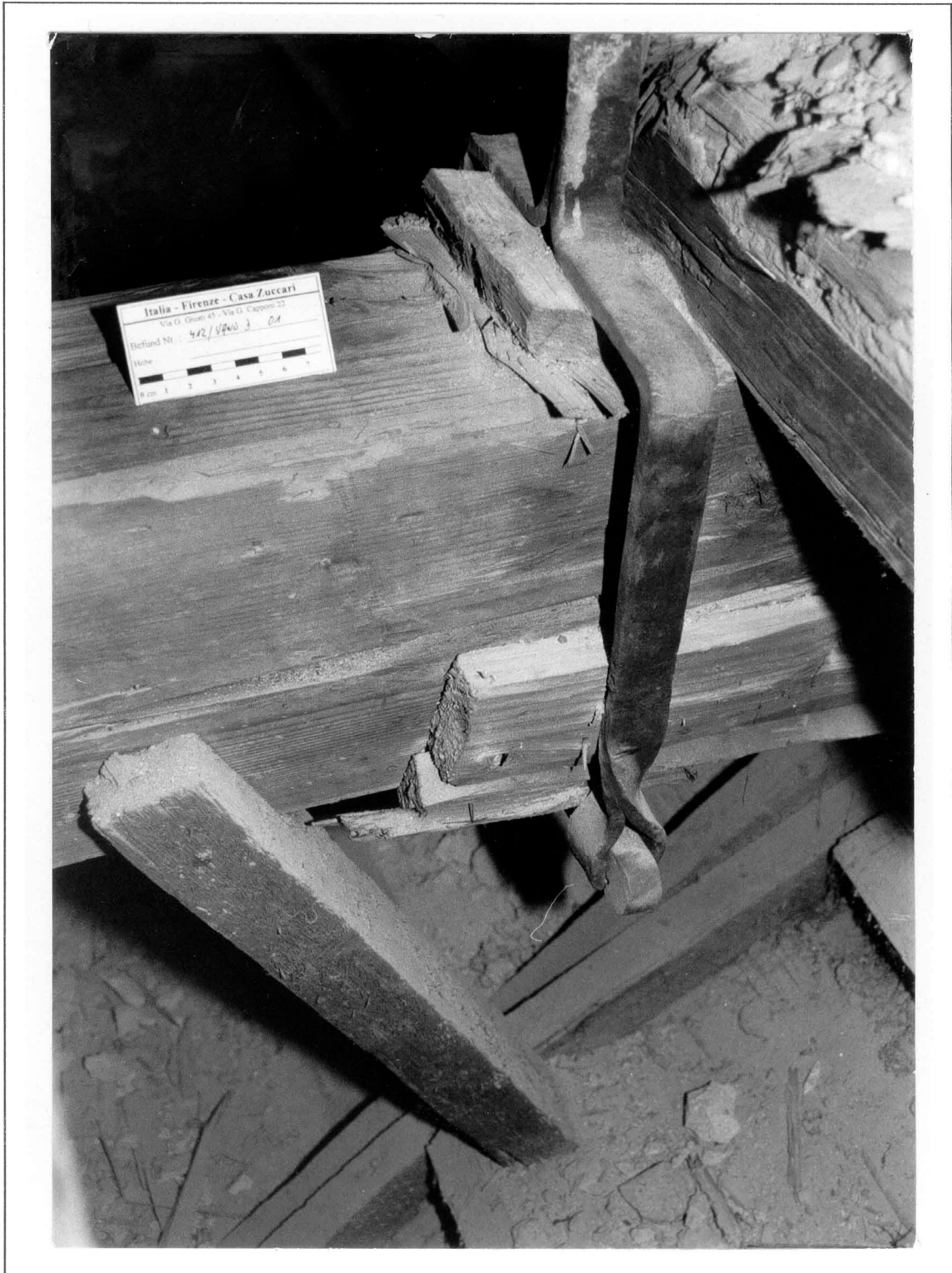
Der Unterzug über dem heutigen Raum 308 mit der Aufhängung aus der zweiten Hälfte des 19. Jahrhunderts
